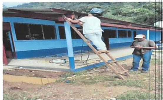
Foto 2: Instalación de canales y bajadas de agua.
